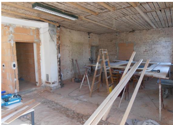
Foto: Feuerwehr Stockern, Innenausbau
