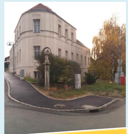
Ein Teil des neu errichteten Gehsteiges, der bis zum Friedhof führt
