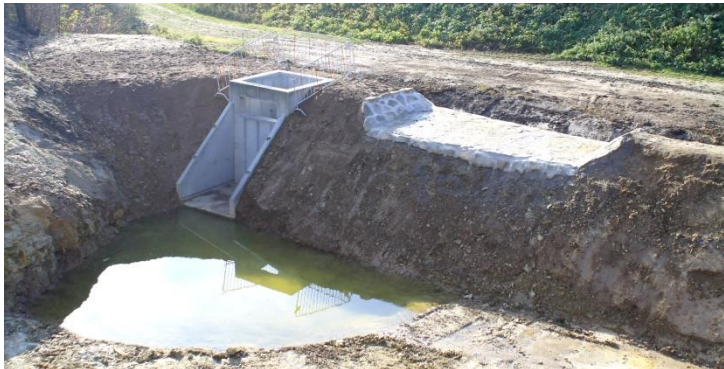
Für die Abwasserbeseitigung musste ein neues Pumpwerk (Foto oben) errichtet werden, das mit dem Anschluss des ersten Gebäudes in Betrieb genommen wird.
